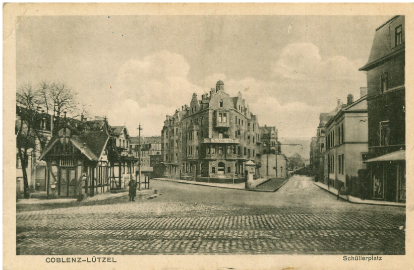
Historische Postkarte mit Blick über den Schüllerplatz auf den Maifelder Hof, links Andernacher Straße, rechts Neuendorfer Straße (1910) Fotograf/Urheber: unbekannt
