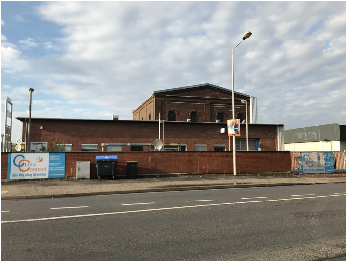
Zweigeschossiges Maschinenhaus des ehemaligen Elektrizitätswerkes Frechen mit jüngerem eingeschossigen Anbau (2020) Fotograf/Urheber: Nicole Schmitz
