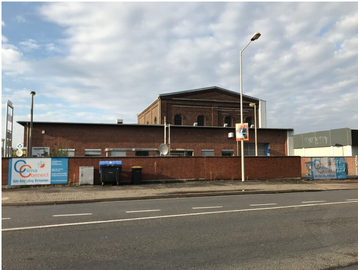
Zweigeschossiges Maschinenhaus des ehemaligen Elektrizitätswerkes Frechen mit jüngerem eingeschossigen Anbau (2020)
