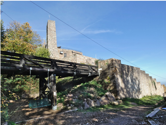
Zugbrücke mit äußerer Ringmauer Fotograf/Urheber: Barbara Hillers, SGD Süd
