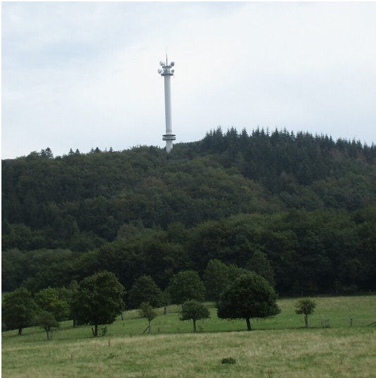
Blick aus westlicher Richtung auf den Richtfunkturm Gänsehalsturm auf der Berghöhe "Gänsehals" bei Bell (2020). Fotograf/Urheber: Franz-Josef Knöchel
