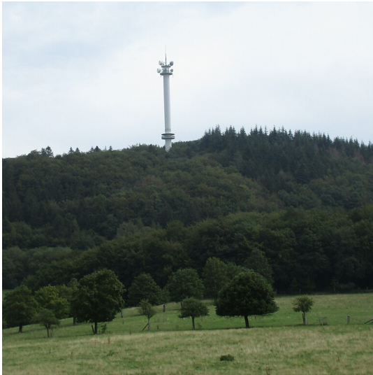
Blick aus westlicher Richtung auf den Richtfunkturm Gänsehalsturm auf der Berghöhe "Gänsehals" bei Bell (2020). Fotograf/Urheber: Franz-Josef Knöchel
