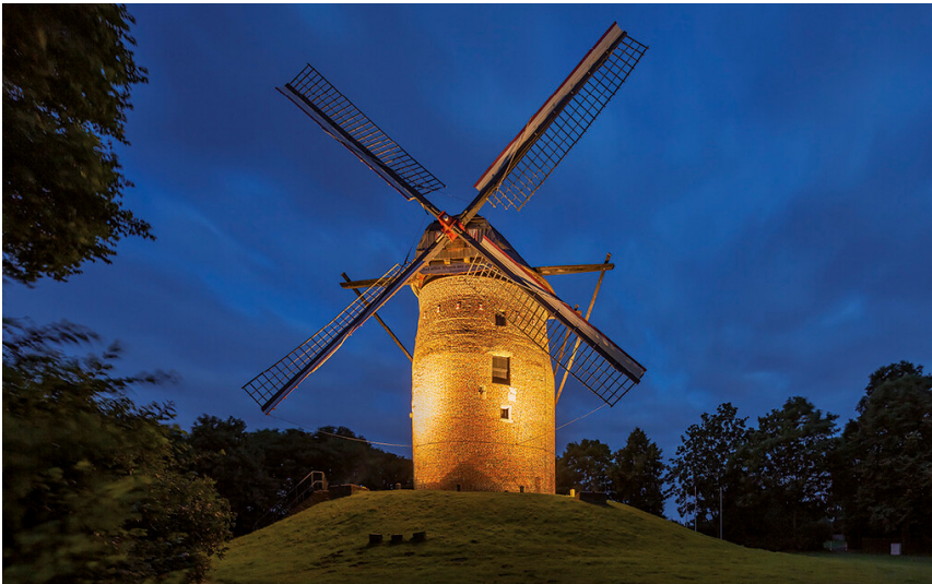
Geismühle in Oppum (2020) Fotograf/Urheber: Holger Klaes
