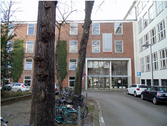
Blick von Westen aus auf die Kaiserin-Augusta-Schule (KAS) am Georgsplatz in Köln-Altstadt/Süd (2021). Fotograf/Urheber: Katharina Grünwald
