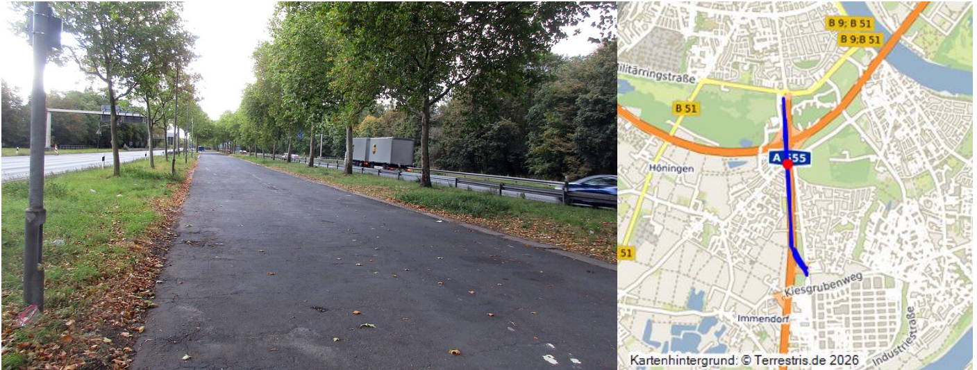
Der letzte Abschnitt der "Geisterbahn"-Trasse der früheren Landstraße L 185 am Ende der Bundesautobahn A 555 am Verteilerkreis Köln (2020). Fotograf/Urheber: Franz-Josef Knöchel
