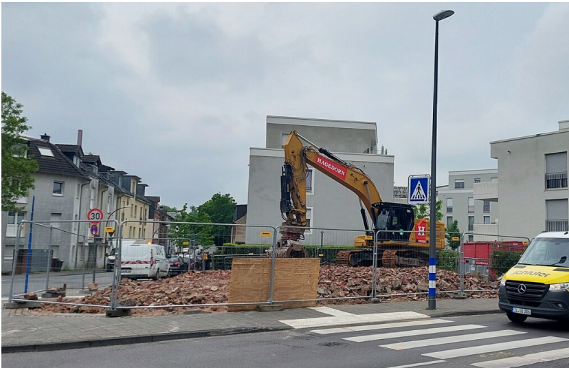
Das für den Stadtteil einst markante "Sonnenhaus" in Köln-Porz ist mit dem im Mai 2026 abgeschlossenen Abriss Geschichte (2026). Fotograf/Urheber: Franz-Josef Knöchel
