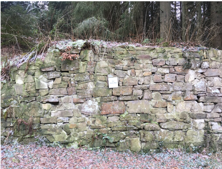
Mauer des Wohnhauses der Spezarder Mühle im Pfengstbachtal (2019) Fotograf/Urheber: Jan Spiegelberg
