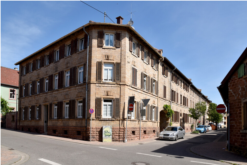
Hartmannstraße 52 Schloßstraße 1 Maikammer (2020) Fotograf/Urheber: Michael Wendler
