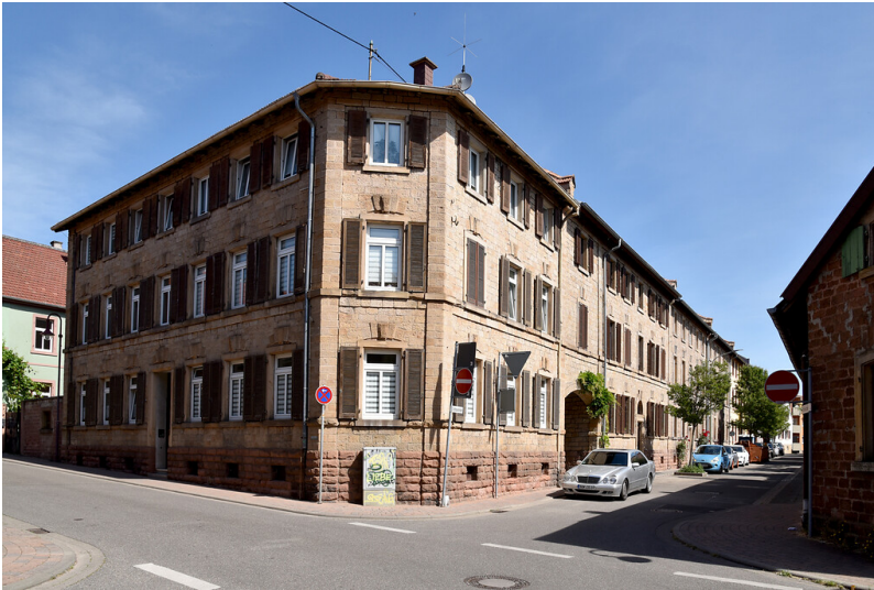
Hartmannstraße 52 Schloßstraße 1 Maikammer (2020) Fotograf/Urheber: Michael Wendler
