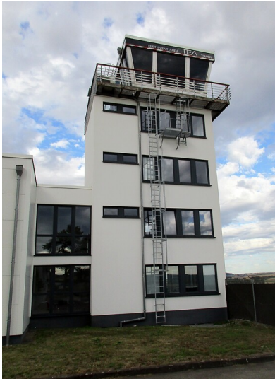
Der Tower des früheren Heeresflugplatzes Mendig, heute ziviler Flugplatz mit angeschlossenem Gewerbegebiet (2020). Fotograf/Urheber: Franz-Josef Knöchel
