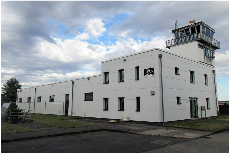
Heute von dem Unternehmen "Test Event Area" genutzte Betriebsgebäude mit dem Tower des früheren Heeresflugplatzes Mendig (2020). Fotograf/Urheber: Franz-Josef Knöchel
