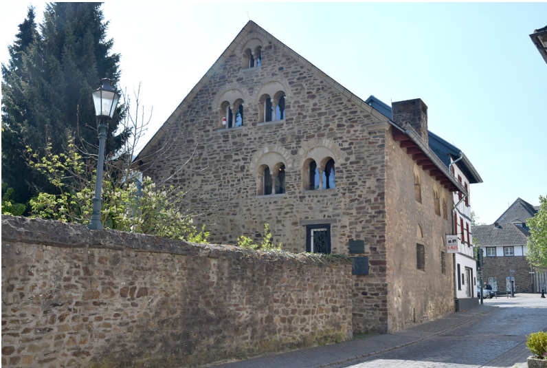
Das Romanische Haus in Bad Münstereifel, Ansicht von der Straße Langenhecke (2017) Fotograf/Urheber: Karin White-Rahneberg
