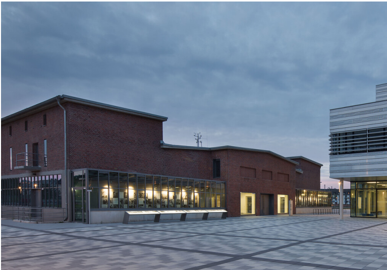
Die Großviehmarkthalle des städtischen Schlachthofs in Düsseldorf-Derendorf (2020), im Eingangsbereich befindet sich heute der Erinnerungsort Alter Schlachthof. Fotograf/Urheber: Eric Fritsch
