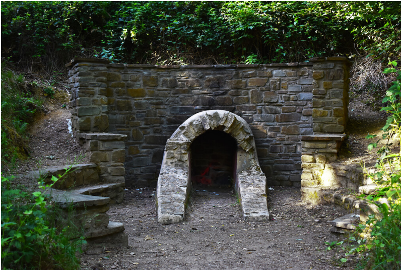
Aufschluss der sogenannten Römerkanals in der Ville bei Buschhoven (2020) Fotograf/Urheber: Jan Kapfer
