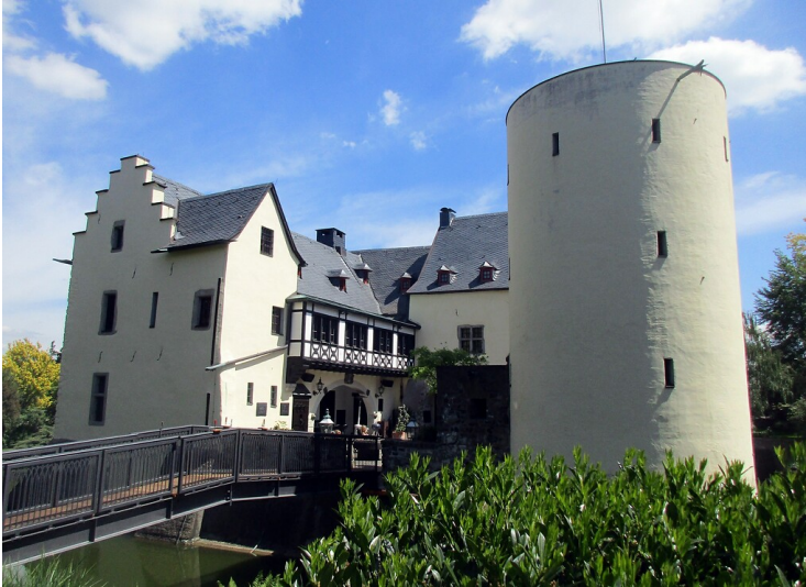
Die westliche Seite der Wasserburg Odenhausen in Wachtberg-Berkum (2020). Fotograf/Urheber: Franz-Josef Knöchel
