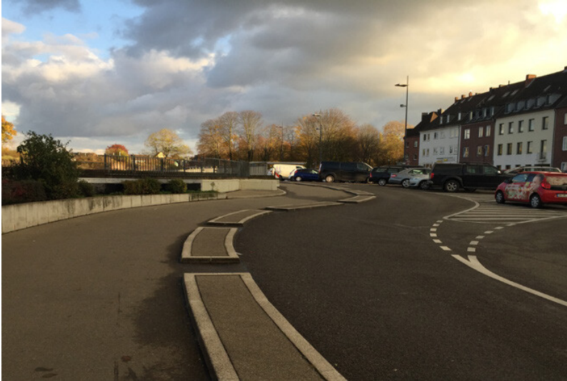
Das Parkdeck Zitadelle in Jülich (2019). Fotograf/Urheber: Hannah Am Ende; Alma Kern
