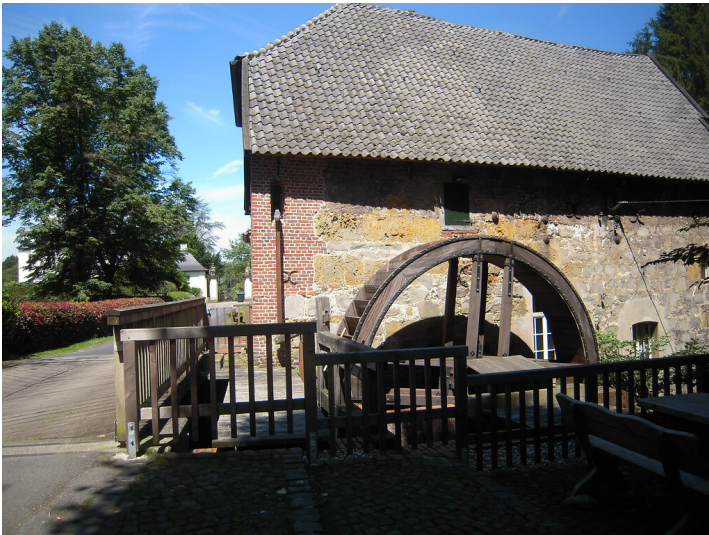
Wassermühle am Schloss Gartrop in Hünxe (2017) Fotograf/Urheber: Hans-Michael Altemüller
