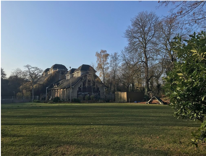
Das historische Klärwerk in Uerdingen, heute "Er-Klärwerk Krefeld" (2018). Fotograf/Urheber: Chri bec
