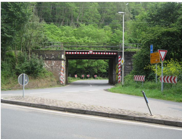
Eisenbahnbrücke über die Bundesstraße 8 unterhalb von Hoch-Elten (2014) Fotograf/Urheber: Claus Weber
