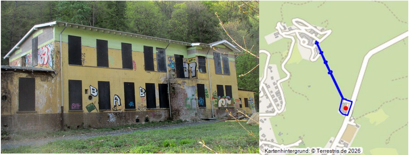
Das Hauptgebäude der früheren Großwäscherei Mesenholl im Schmelztal bei Bad Honnef mit der 2018 aufgebrachten provisorischen Dachkonstruktion (2020). Fotograf/Urheber: Franz-Josef Knöchel
