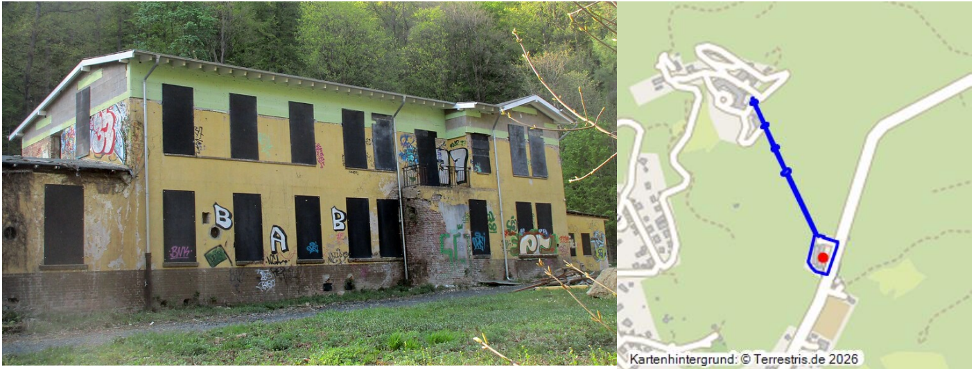
Das Hauptgebäude der früheren Großwäscherei Mesenholl im Schmelztal bei Bad Honnef mit der 2018 aufgebrachten provisorischen Dachkonstruktion (2020). Fotograf/Urheber: Franz-Josef Knöchel
