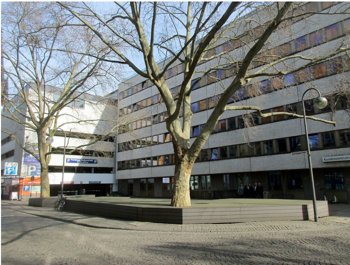
Blick in nördliche Richtung über den Karl-Körper-Platz in Köln-Altstadt-Nord (2020). Fotograf/Urheber: Franz-Josef Knöchel
