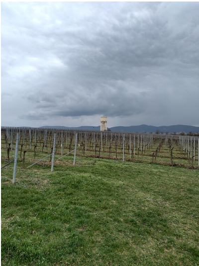
Wasserturm bei Duttweiler (2020) Fotograf/Urheber: Matthias C.S. Dreyer
