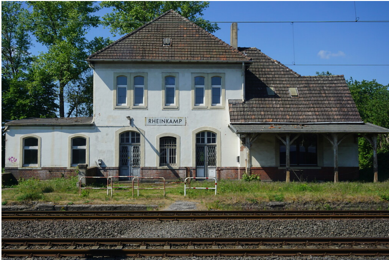
Empfangsgebäude Bahnhof Rheinkamp, Ansicht von der Gleisseite (2020) Fotograf/Urheber: Claus Weber
