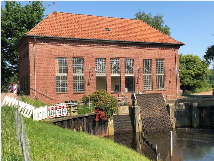
Ostansicht auf das Schöpfwerk Vaalermoor Fotograf/Urheber: unbekannt
