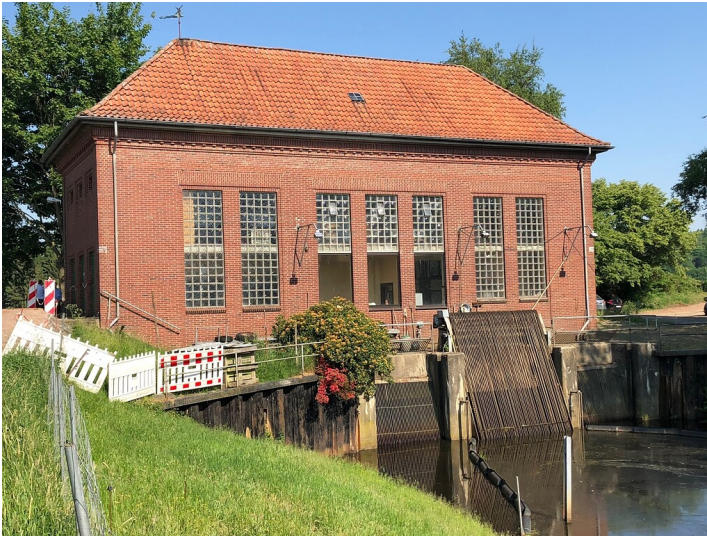
Ostansicht auf das Schöpfwerk Vaalermoor Fotograf/Urheber: unbekannt
