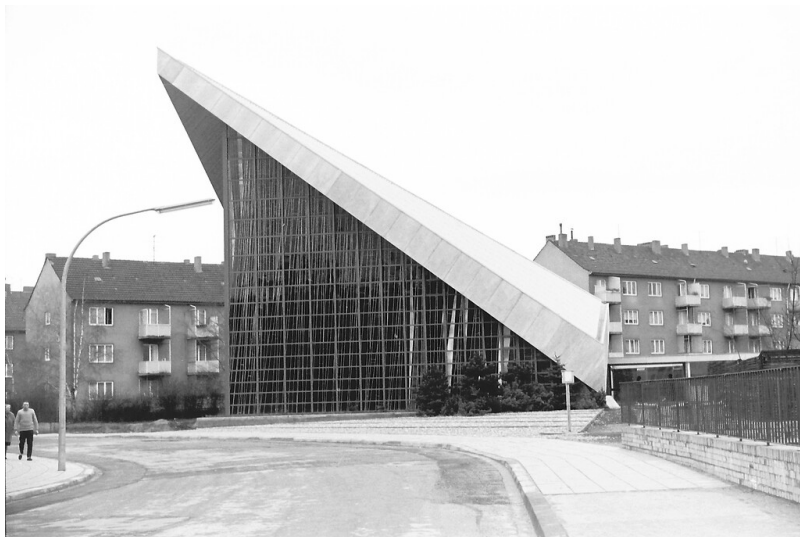
Zeitgenössische Aufnahme des 1965 neu erbauten Gebäudes der evangelischen Stephanuskirche in Köln-Riehl. Fotograf/Urheber: Jürgen Peters
