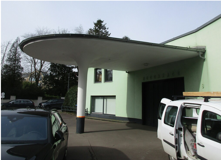
Das von einer zentralen Säule ("Pilzsäule") getragene Dach aus Spannbeton der früheren Tankstelle "Zoogarage" in der Stammheimer Straße in Köln-Riehl (2020). Fotograf/Urheber: Franz-Josef Knöchel
