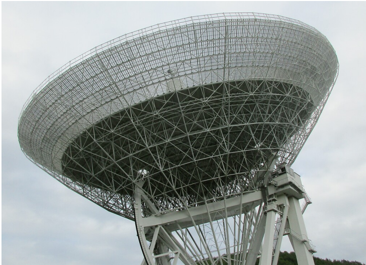
Das Radioteleskop Effelsberg bei Bad Münstereifel gehört mit 100 Meter Durchmesser seines Parabolspiegels zu den größten vollbeweglichen Radioteleskopen der Erde (2020). Fotograf/Urheber: Franz-Josef Knöchel
