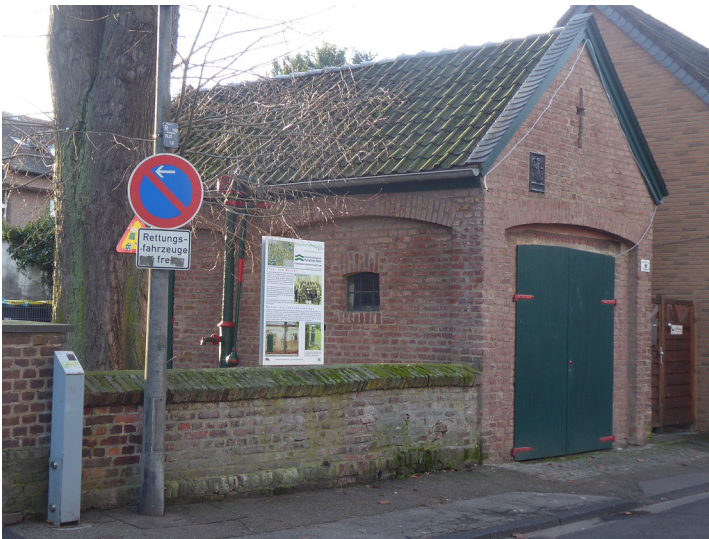
Abbildung 1: Erzählstation Pumpe am Spritzenhaus (2019) Fotograf/Urheber: Reinhard Zeese
