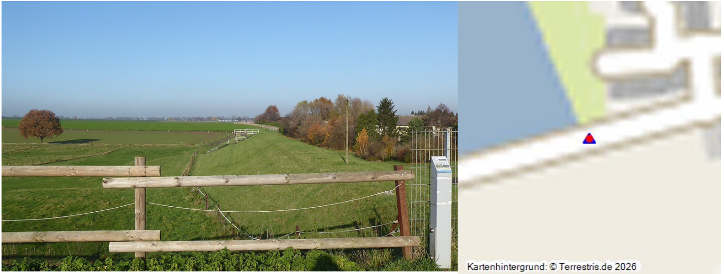
Abbildung 1: Erzählstation Talsperre Sinthern (2019) Fotograf/Urheber: Reinhard Zeese
