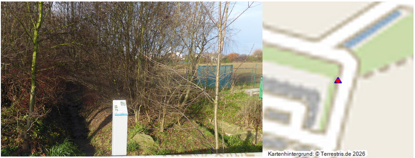
Abbildung 1: Erzählstation Abtsmühlenbach mit Sohlgleite (links) und Betonkaskade (rechts) (2019) Fotograf/Urheber: Reinhard Zeese
