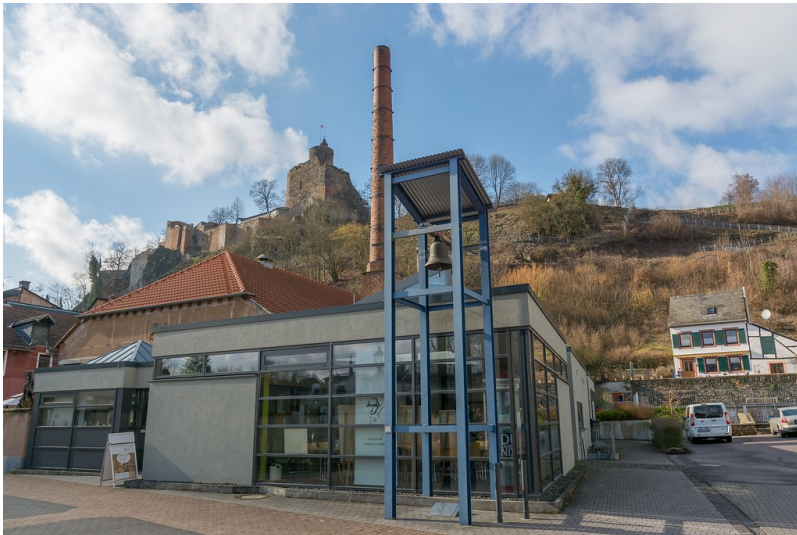
Ansicht des Museums Glockengießerei Mabilon in Saarburg (2019) Fotograf/Urheber: unbekannt
