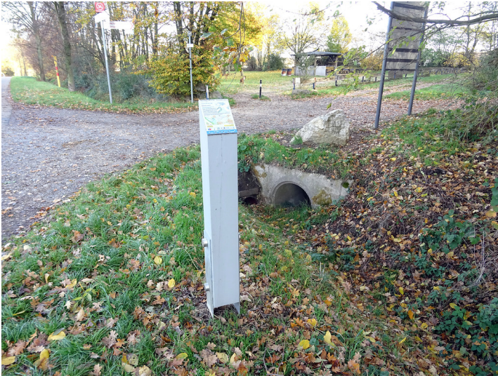
Abbildung 1: Aufteilungsbauwerk Beileitung südwestlich von Glessen (2018) Fotograf/Urheber: Reinhard Zeese
