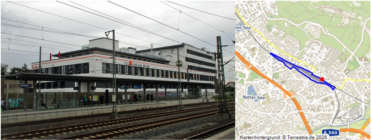
Blick auf den Bahnhof Troisdorf nach dem Um- und Neubau (2019) Fotograf/Urheber: Franz-Josef Knöchel
