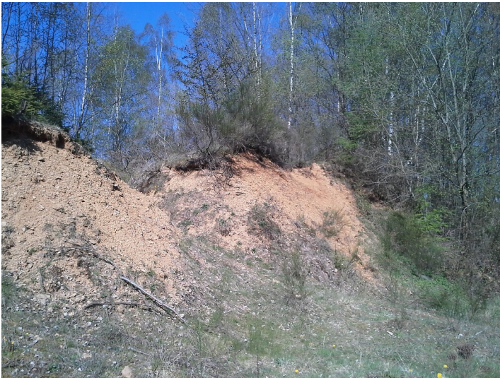
Ehemalige Lehmgrube Cronrath (2019) Fotograf/Urheber: Hildegard Coenen
