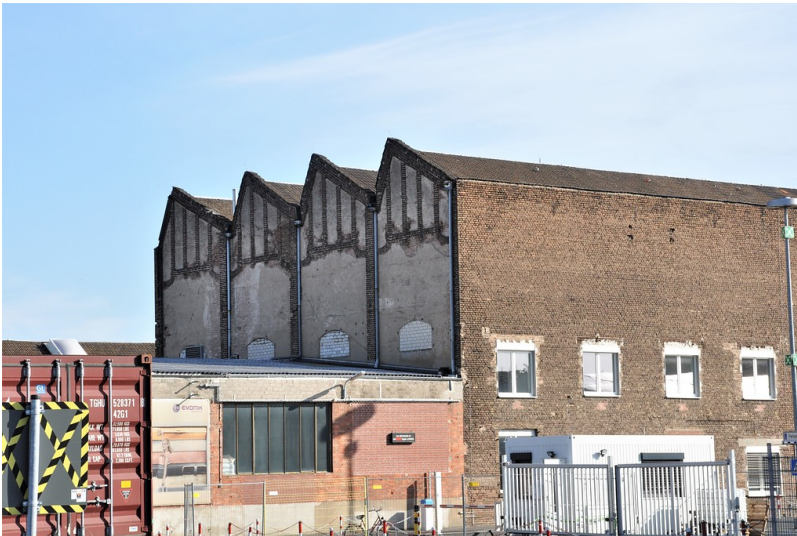
Teile der Fabrikanlage von Evonik in Bonn-Beuel (2019). Fotograf/Urheber: Sandro Golia
