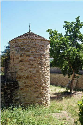
Alter Befestigungsturm an der Südwestecke der Vorburg der alten Wasserburg Deidesheim (2019) Fotograf/Urheber: Sarah Krieger
