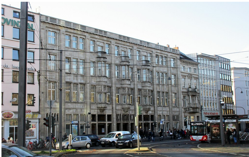
Das Bing-Haus am Kölner Neumarkt Nr. 15-21 (2019), einstiges Geschäftshaus und heute Sitz des Gesundheitsamts Köln. Fotograf/Urheber: Franz-Josef Knöchel
