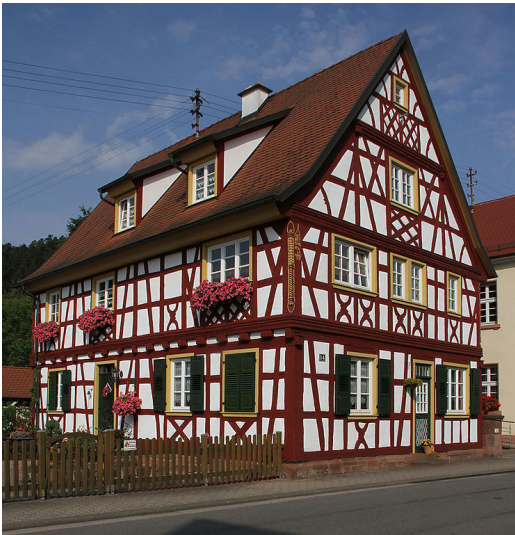
Fachwerkhaus in der Hauptstraße in Bobenthal (2013) Fotograf/Urheber: Eichmann, Gerd
