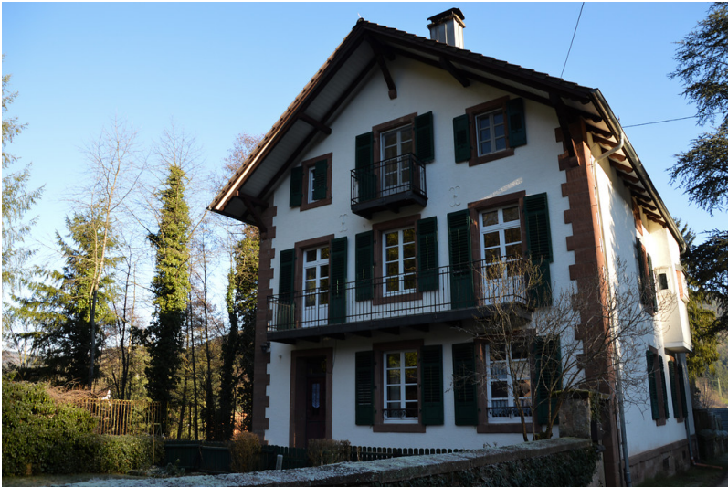
Blick auf die hintere Fassadenseite der Villa Bobenthal von der Forststraße aus (2019) Fotograf/Urheber: Laura Hans
