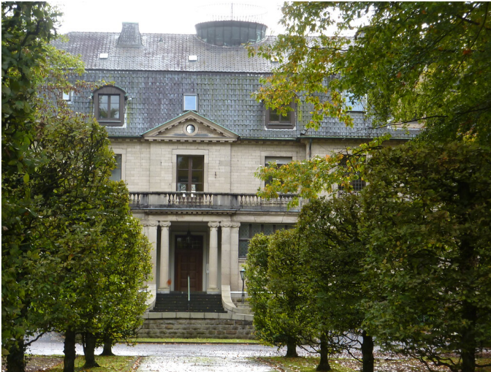
Eingangportal des Hauses Hohbeck (2019) Fotograf/Urheber: Silke Junick
