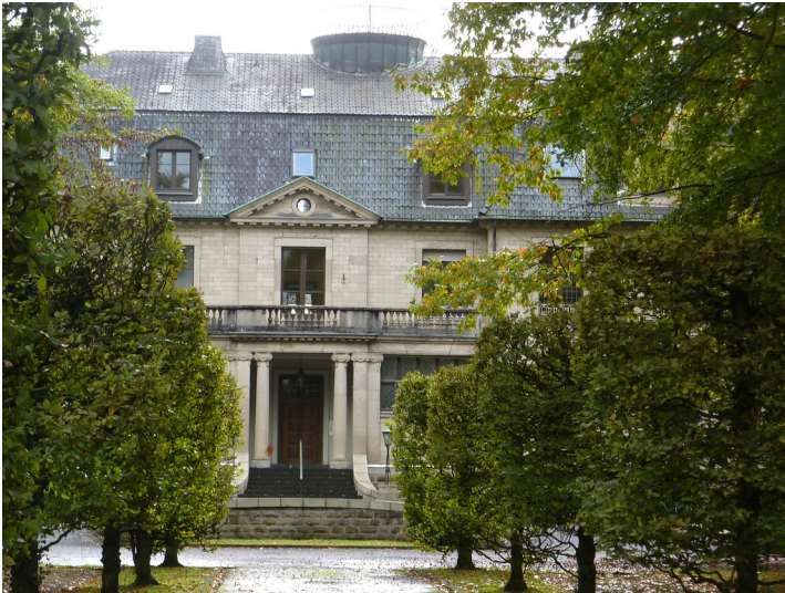
Eingangportal des Hauses Hohbeck (2019) Fotograf/Urheber: Silke Junick
