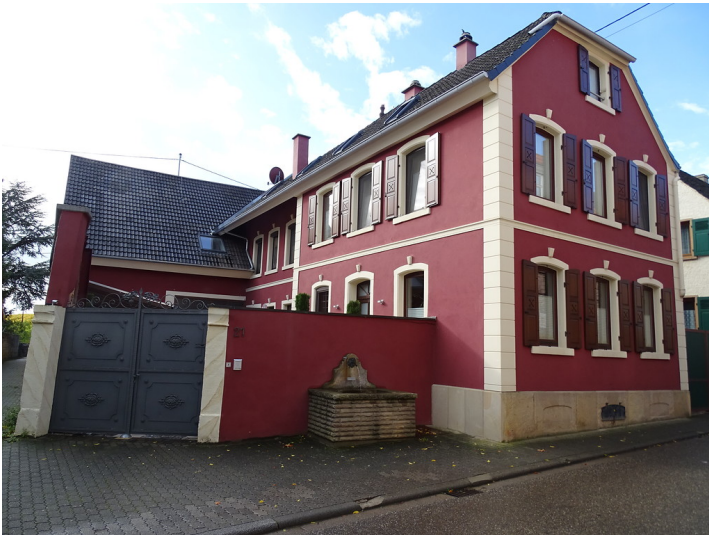
Wohnhaus Hauptstraße 21 in Alsterweiler (2019) Fotograf/Urheber: Matthias C.S. Dreyer
