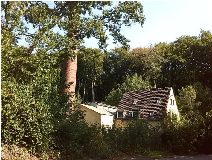
Kesselhaus der leerstehenden Klinik Aprath (2019) Fotograf/Urheber: Silke Junick
