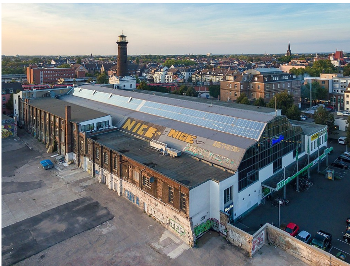
Das Gelände der früheren Helios-Elektrizitäts AG in Köln-Ehrenfeld mit der Rheinlandhalle im Vordergrund und dem Helios-Leuchtturm dahinter (2016). Fotograf/Urheber: Superbass
