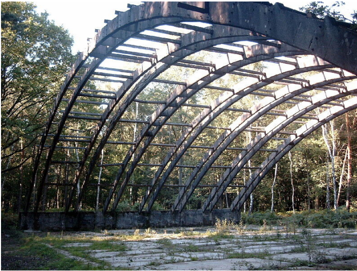
Das Baudenkmal Rundbogenhalle am Standort Fliegerhorst Venlo-Herongen (2005). Fotograf/Urheber: Frank Ulbrich
