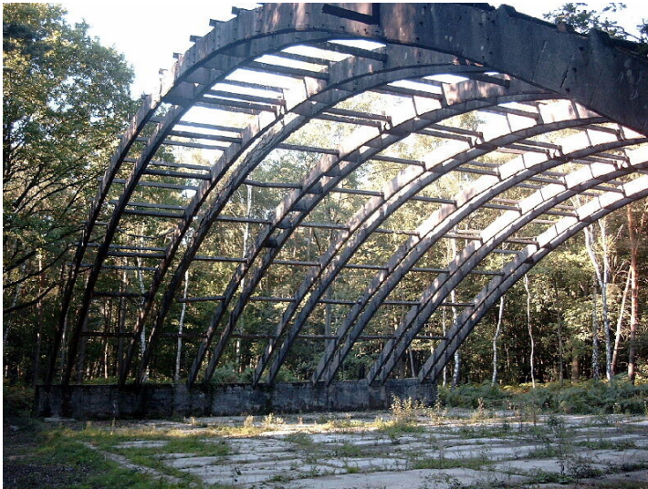
Das Baudenkmal Rundbogenhalle am Standort Fliegerhorst Venlo-Herongen (2005). Fotograf/Urheber: Frank Ulbrich
