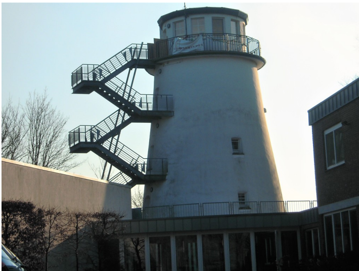
Die Schaephuysener Mühle in Rheurdt, heute Teil der Jugendbildungsstätte St. Michaelsturm (2016) Fotograf/Urheber: Hans-Michael Altemüller
