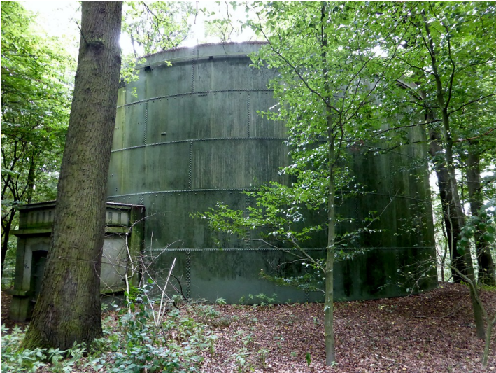
Trinkwasserhochbehälter Hoher Busch in Viersen (2019) Fotograf/Urheber: Lukas Gielen
